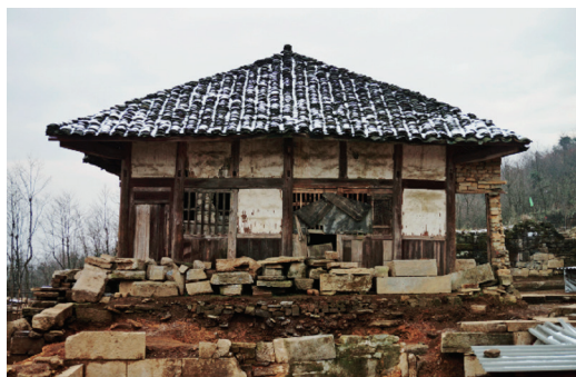
海潮寺西立面施工前
