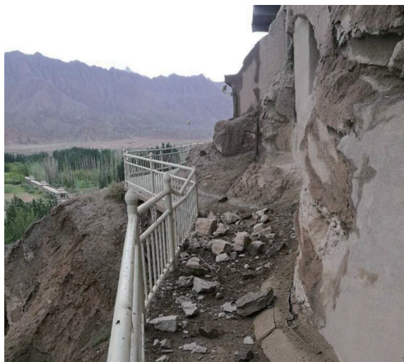
图 3-37 2019 年丝绸之路—克孜尔石窟 53 窟危岩体坍塌（数据来源于新疆龟兹研究院）
