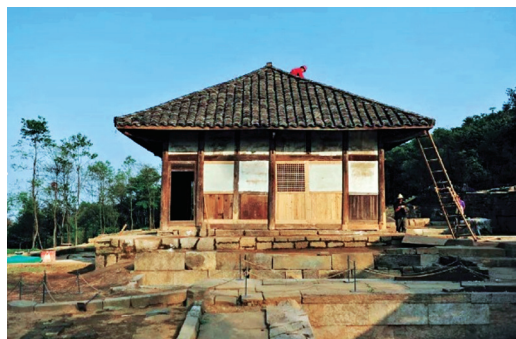
海潮寺西立面施工后
