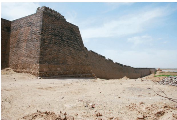
图5 宁夏横城村长城3段夯土墙包砖之后（摄影：陈晓桦，2007年）
