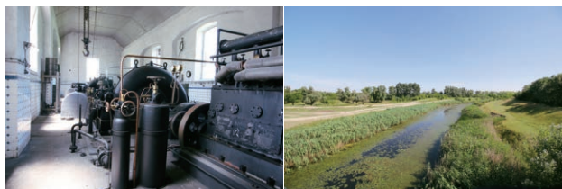
图12 普拉夫纳柴油水泵站与莫斯通佳河河道及堤坝(摄影:高晨翔)
