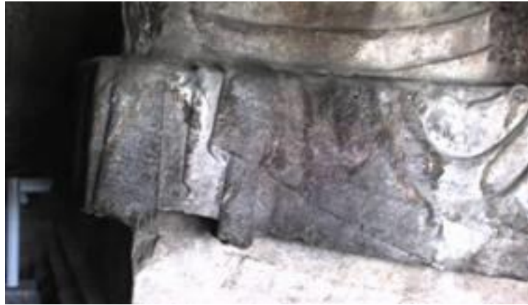
图 3-5 潜溪寺表层风化
