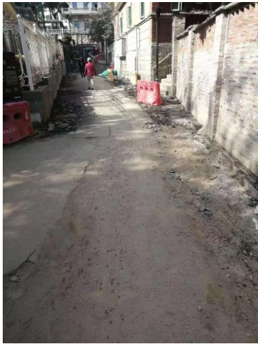
图 4-31 鼓浪屿电力扩容二期工程
