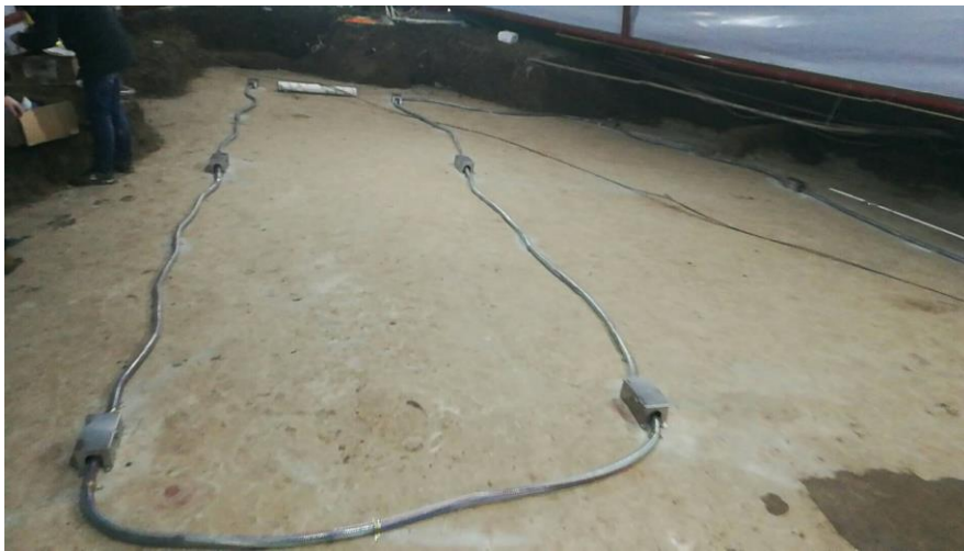
图 3-14 静力水准仪对宝顶山圆觉洞顶板沉降进行监测
