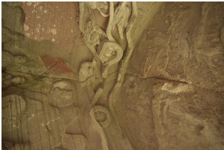
图 3-20 北山石刻 176 号龕弥勒下生经变相处裂隙 2
