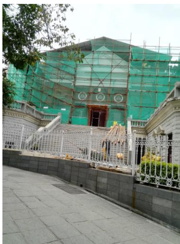
图 3-4 三一堂屋顶修缮
