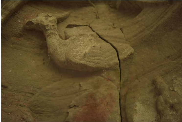
图 3-19 北山石刻 176 号龕弥勒下生经变相处产生裂隙 1
