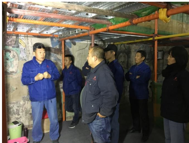
图 5-3 莫高窟第 465 窟壁画保护修缮工程施工现场
