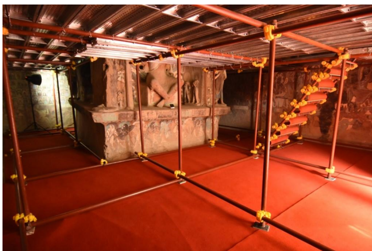
图 5-8 莫高窟第 254 窟壁画彩塑保护修缮工程搭设脚手架现场
