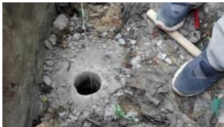
图 4-7 西山地下水位监测
