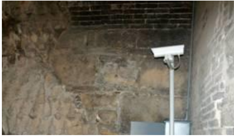
图 3-16 擂鼓台南洞渗漏水监测
