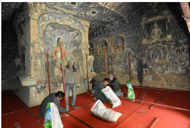
图 5-7 莫高窟第 254 窟壁画彩塑保护修缮工程搭设脚手架现场
