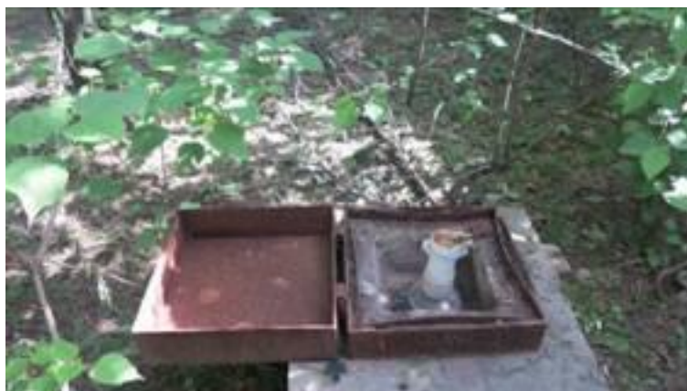
图 4-8 西山地下水位监测
