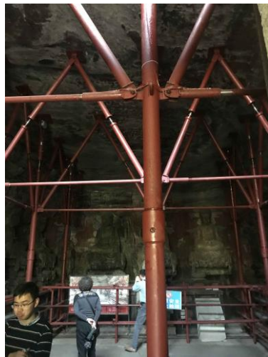
图 3-17 宝顶山圆觉洞石窟顶板的临时支撑及应力监测 1
