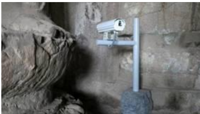
图 3-1 潜溪寺渗漏水监测
