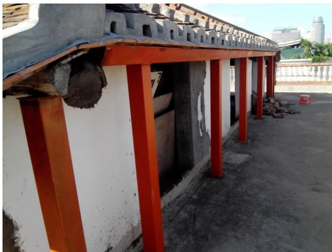
图 3-2 英商亚细亚火油公司旧址屋顶檐口加固
