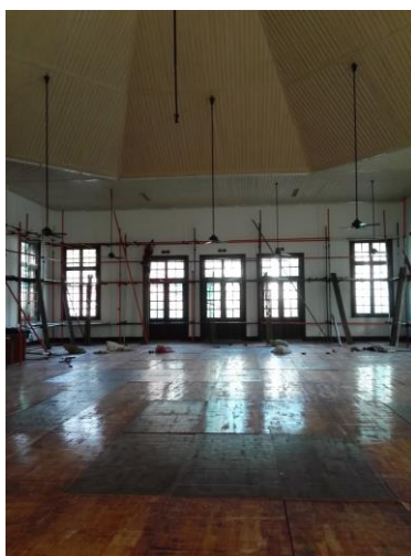
图 3-5 三一堂屋顶修缮 2
