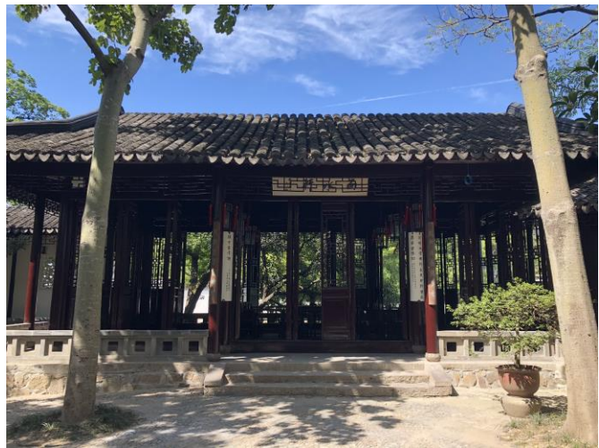
图 4-18 面水轩维修后
